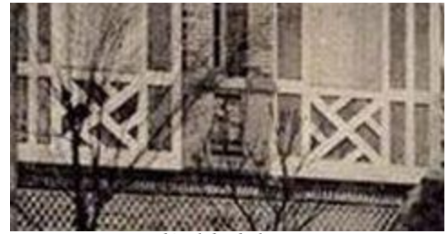
détail des balcons
