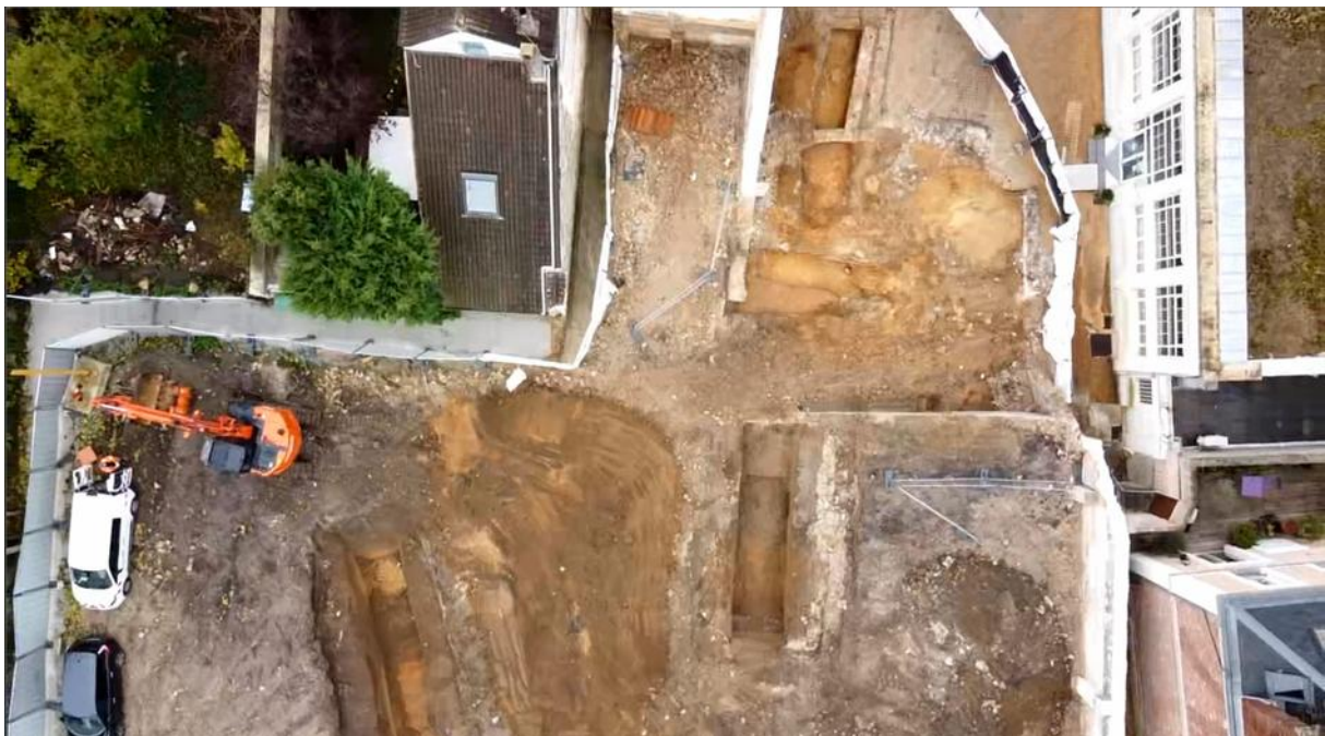
Fig. 6 : vue aérienne du chantier prise par drone et parallèlement à la rue d'Angiviller © Ph. J Vallot
