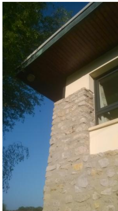
mur en pierre de Prasville et avant-toit en sapin du Nord
