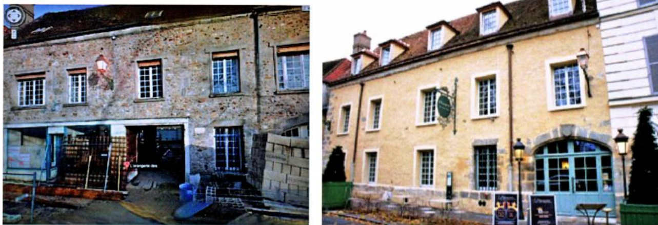
Fig 12. Ancienne maison des Trois Roys : Façade en cours de restauration et après restauration.
